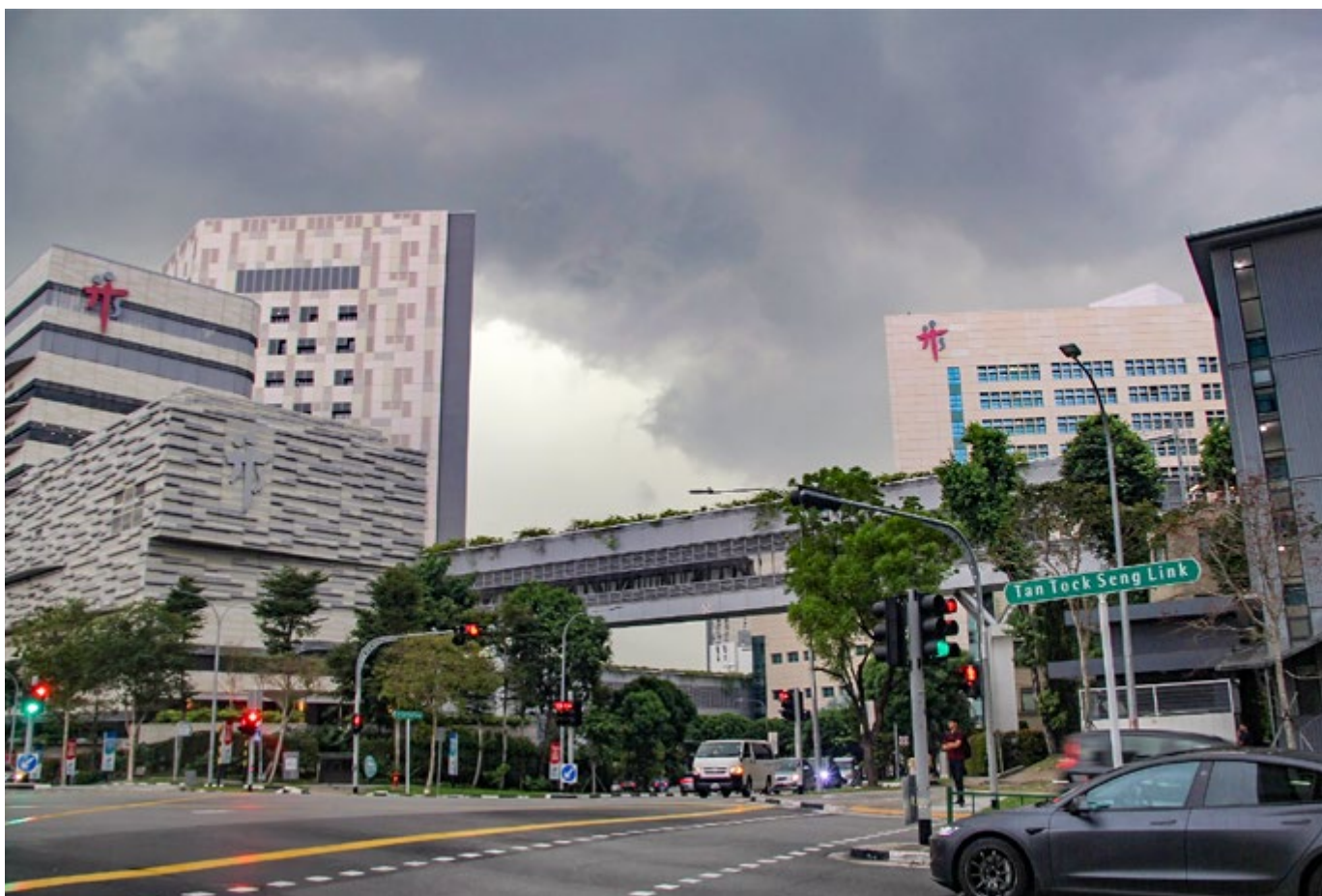
Fragment kompleksu szpitali Tan Tock Seng Hospital, na budynkach widoczne logo „TTS”, a ulica nazwana jest na cześć fundatora.
